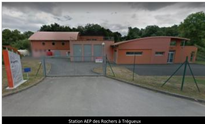
Station AEP des Rochers à Trégueux
