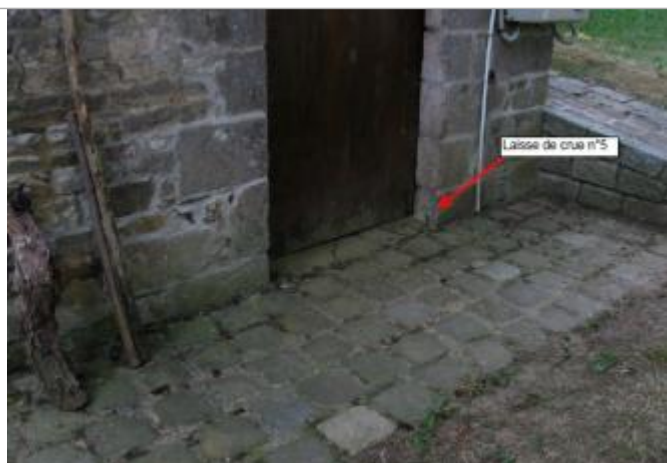
Photographie de 2003 lors du relevé par BCEOM
