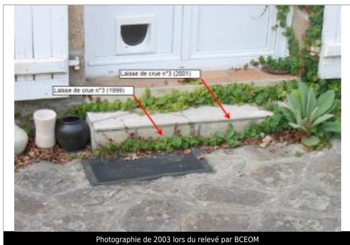
Photographie de 2003 lors du relevé par BCEOM
