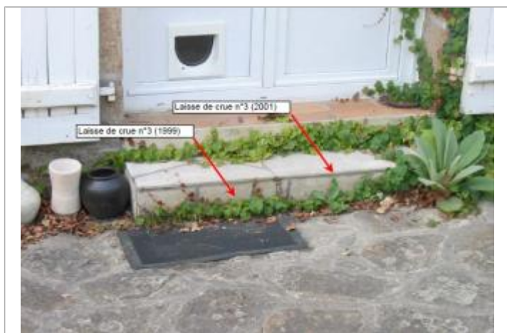
Photographie de 2003 lors du relevé par BCEOM
