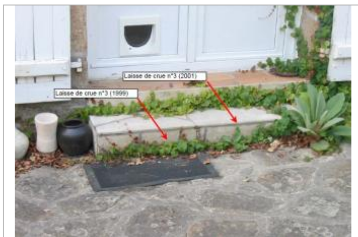
Photographie de 2003 lors du relevé par BCEOM
