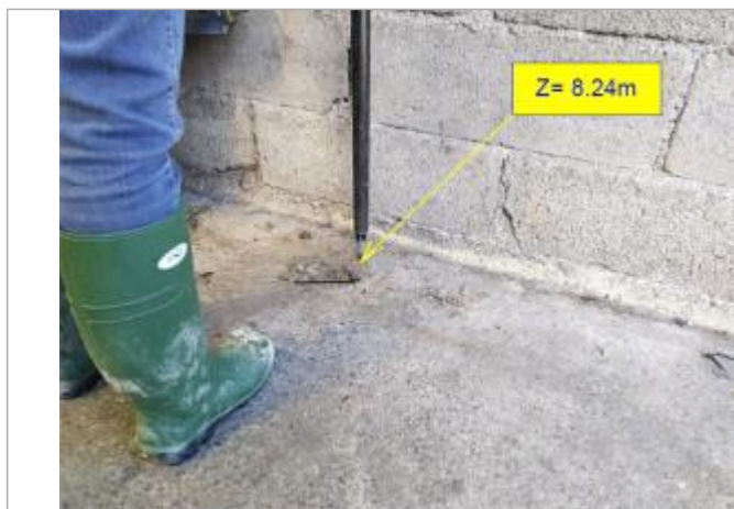
Nivellement du sol de l'atelier par la DDTM 22 en octobre 2021
