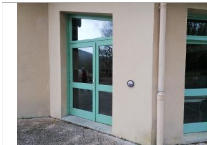
Repère de crue normalisé installé sur le mur de la salle des fêtes
