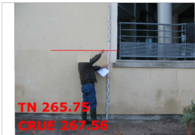
Cours Stanislas 88500 MIRECOURT - Laisse de crue du 03/10/2006. 267,56m/NGFIGN69
