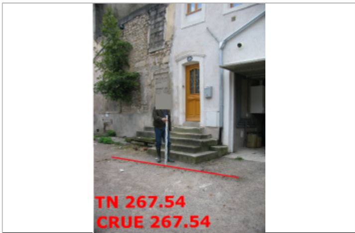
48 rue Vuillaume 88500 MIRECOURT - Laisse de crue du 03/10/2006. 267,54m/NGFIGN69
