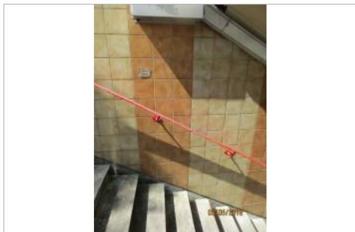
Projet de repère 1910 - Auteur : Artelia
