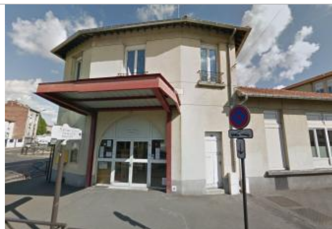
Projet de repère 1910 - Auteur: Artelia
