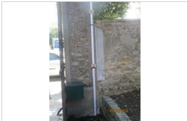
Projet de repère 1924 - Auteur : Artelia
