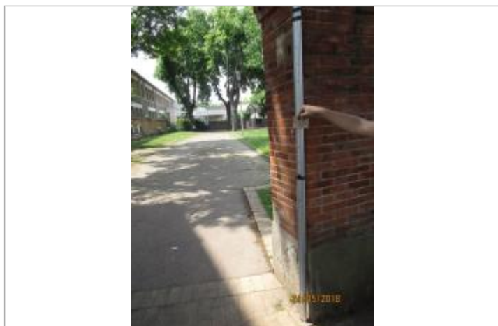
Projet de repère 1910 - Auteur : Artelia
