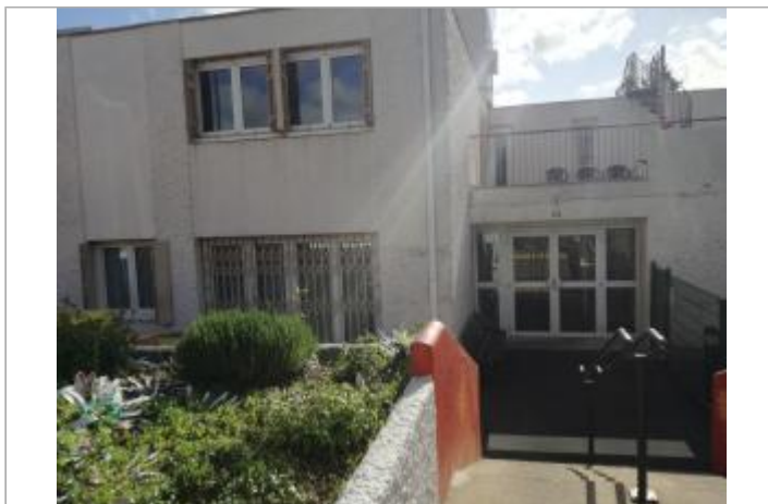
Projet de site - Auteur: Artelia
