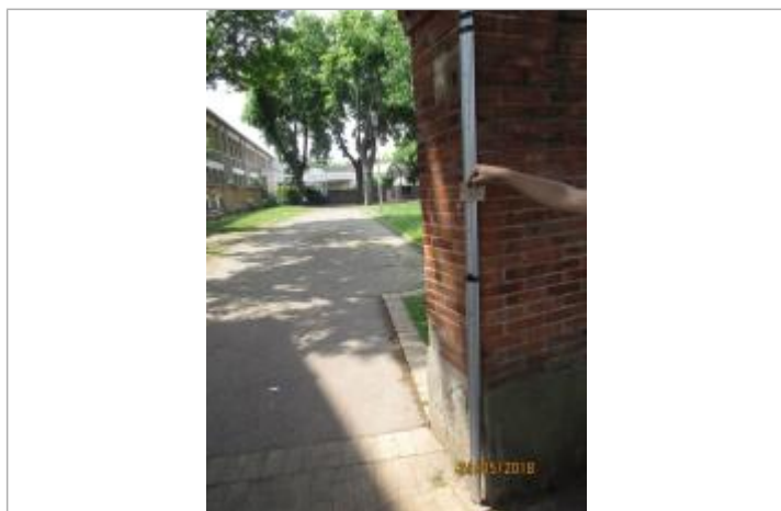
Projet de repère 1910 - Auteur : Artelia
