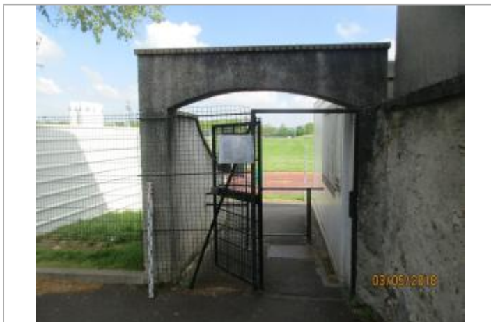
Projet de site - Auteur: Artelia
