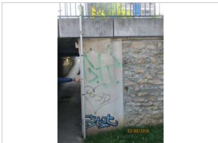
Projet de repère 1910 - Auteur : Artelia
