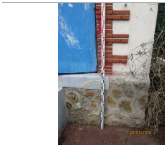
Projet de repère 1924 - Auteur: Artelia
