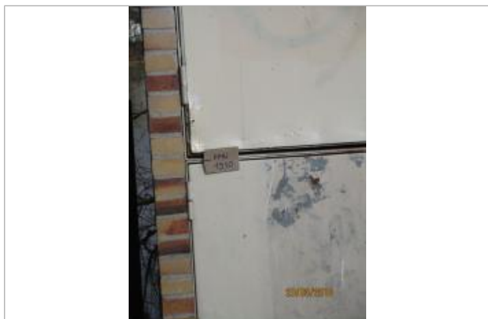
Projet de repère 1910 - Auteur : Artelia
