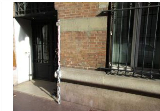
Projet de repère 1924 - Auteur : Artelia
