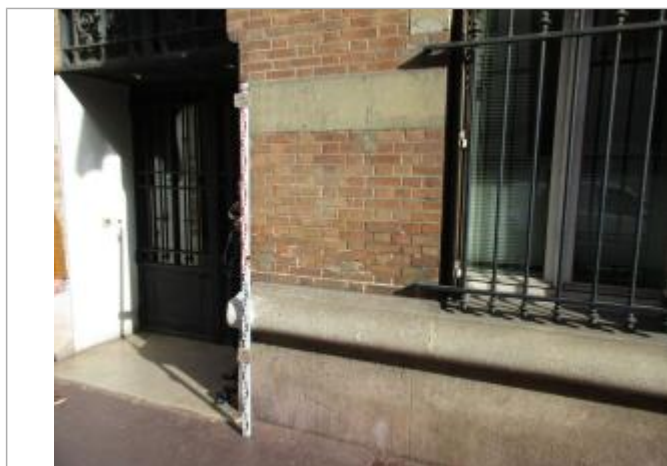
Projet de repère 1910 - Auteur : Artelia
