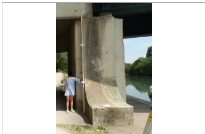
Projet de repère 1910 - Auteur : Artelia
