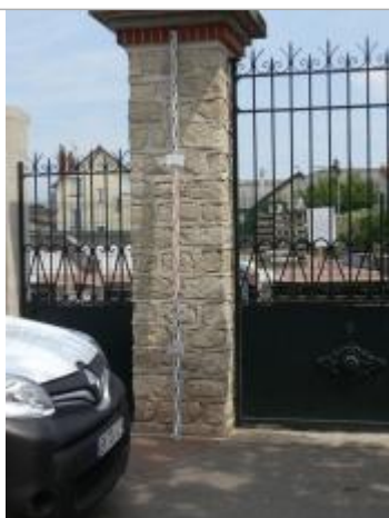
Projet de repère 1924 - Auteur : Artelia
