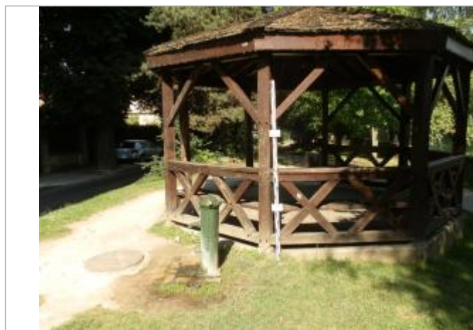
Projet de repère 1910 - Auteur : Artelia
