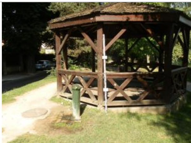
Projet de repère 1924 - Auteur : Artelia
