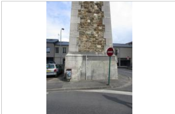
Projet de site - Auteur: Artelia
