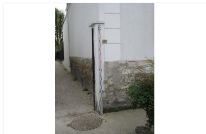
Projet de repère 1924 - Auteur: Artelia
