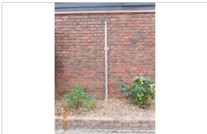
Projet de repère 1910 - Auteur : Artelia
