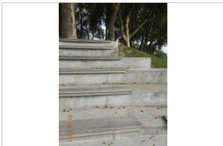
Projet de repère 1910 - Auteur: Artelia
