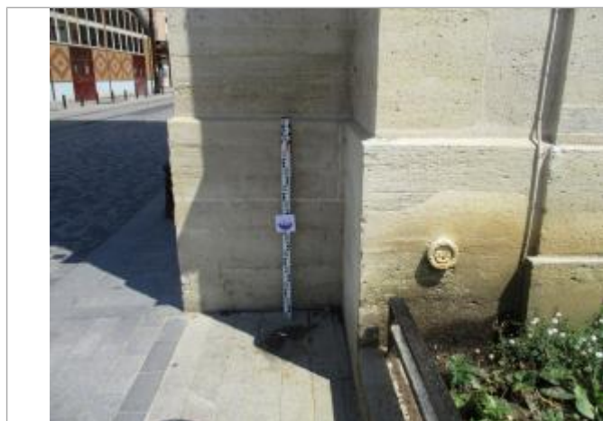
Projet de repère 1910 - Auteur: Artelia
