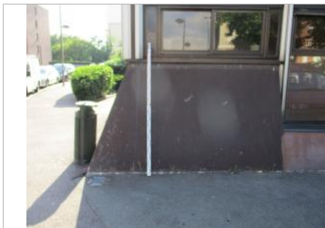
Projet de repère 1910 - Auteur : Artelia
