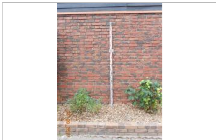
Projet de repère 1910 - Auteur : Artelia
