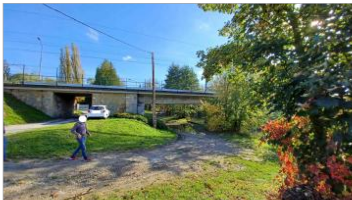
Poteau EDF en ciment, en aval immédiat du pont SNCF, sur rive droite.
