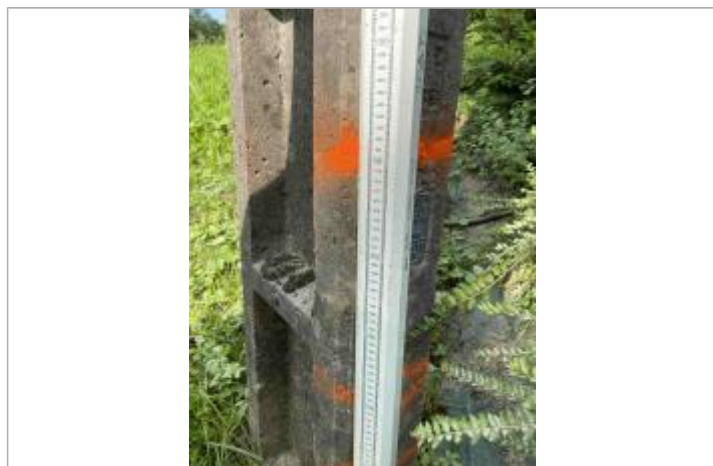
Marque de peinture sur poteau EDF à 80,5 cm/sol.
