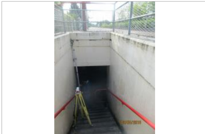
Projet de site - Auteur: Artelia
