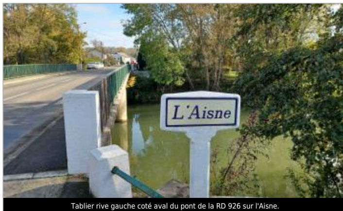
Tablier rive gauche coté aval du pont de la RD 926 sur l'Aisne.
