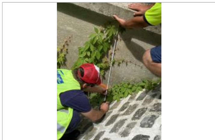
Marque de peinture sur tablier du pont à 1 m/ bas du tablier.
