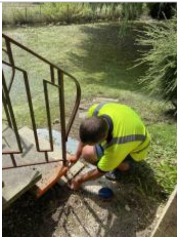
Marque de peinture sur la seconde marche en partant du bas à 16 cm du haut de la première marche.
