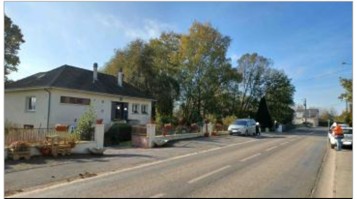
Marche d'escalier à l'arrière de la maison située 15 route du Docteur Brédant
