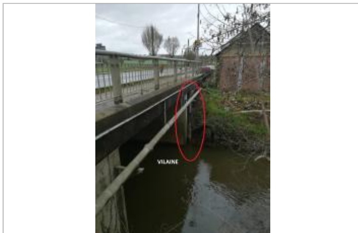
Echelle limnimétrique de la grenouillère pont RD 777 en 2019
