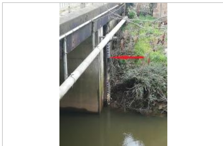
Echelle limnimétrique de la grenouillère pont RD 777
