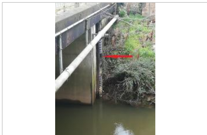
Echelle limnimétrique de la grenouillère pont RD 777
