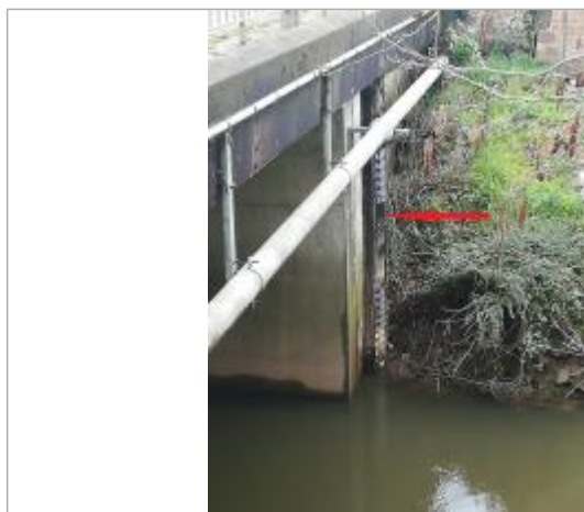
Echelle limnimétrique de la grenouillère pont RD 777
