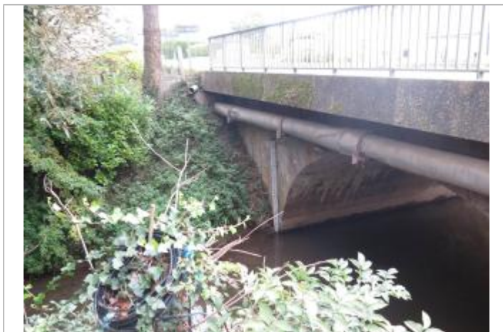
Pont d'Etrelles - Aval du Pont D178
