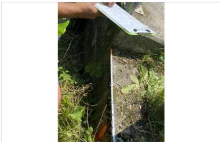
Marque de peinture sur bordure en ciment à 66 cm (plan horizontal) de la fissure.
