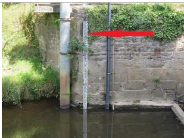
Echelle limnimétrique de la station de Saint-Jouan-de-l'Isle
