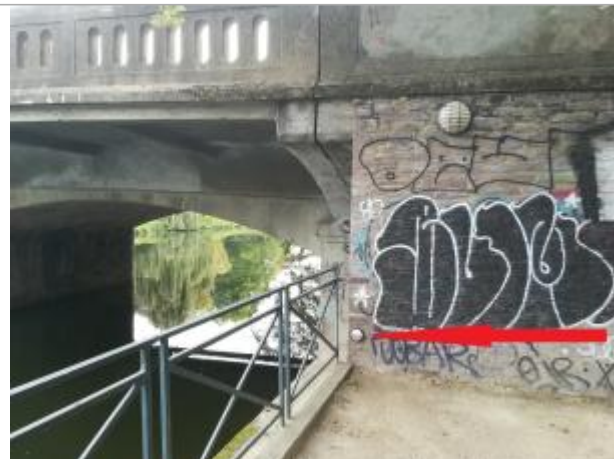
Pile aval rive gauche du pont Laënnec promenade Pierre Gardin de la Gerberie
