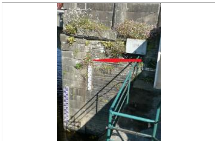
Echelle limnimétrique de la station de Pont Routier à Châteaulin
