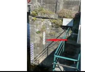
Echelle limnimétrique de la station de Pont Routier à Châteaulin
