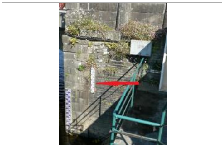
Echelle limnimétrique de la station de Pont Routier à Châteaulin
