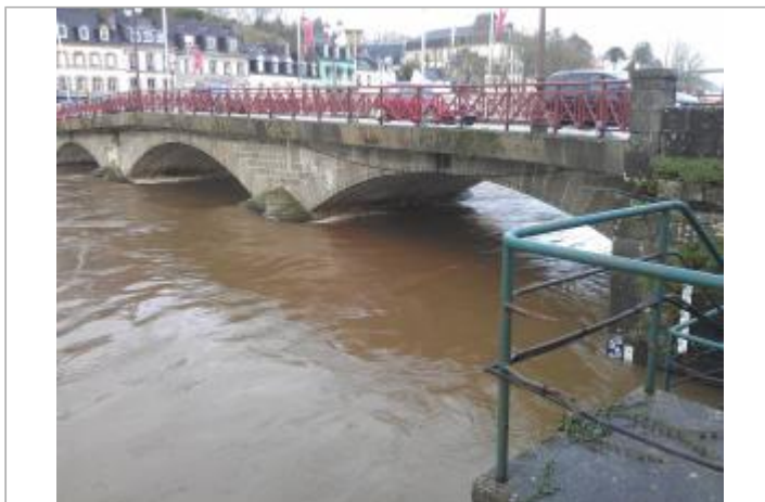
Station limnimétrique de Pont Routier en crue le 2 janvier 2014
