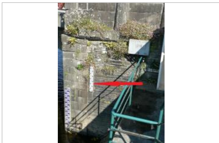
Report du niveau atteint au niveau du pont sur l'échelle limnimétrique
