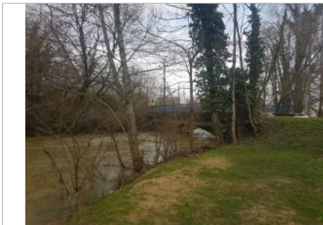
Pont de la Rue du Port, sur la Saulx
