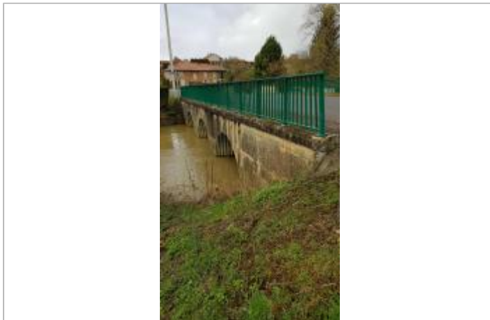
Côté aval du pont sur la Chée sur la RD62
