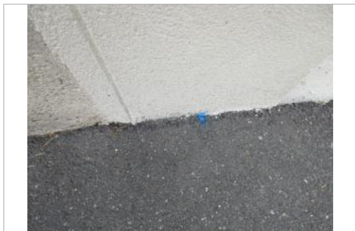
Projet de repère de crue reconstruit 1910 - Auteur : Artelia
