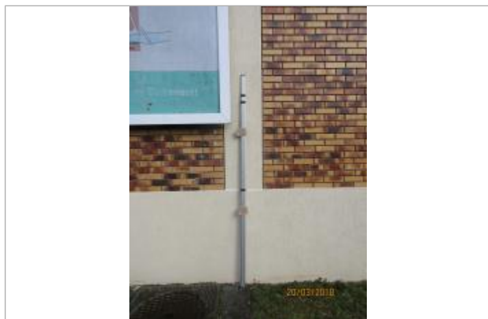
Projet de repère 1910 - Auteur: Artelia
